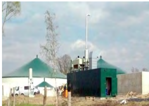
Seitenansicht der Biogasanlage
