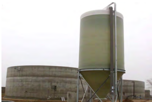
Bauarbeiten und Getreidesilo
